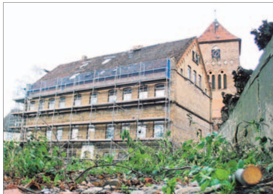
An Stelle des abgerissenen, so genannten „Schweinestalls“ soll auf dem Hofgelände zwischen Kirchplatz und Bürgerwiese ein Veranstaltungssaal entstehen. Das alte Gebäude der Geschwister-Scholl-Schule ist zur Sanierung eingerüstet. Ausschreibungen für Baugewerke sind auf den Weg gebracht. OZ-Foto: W. E.
